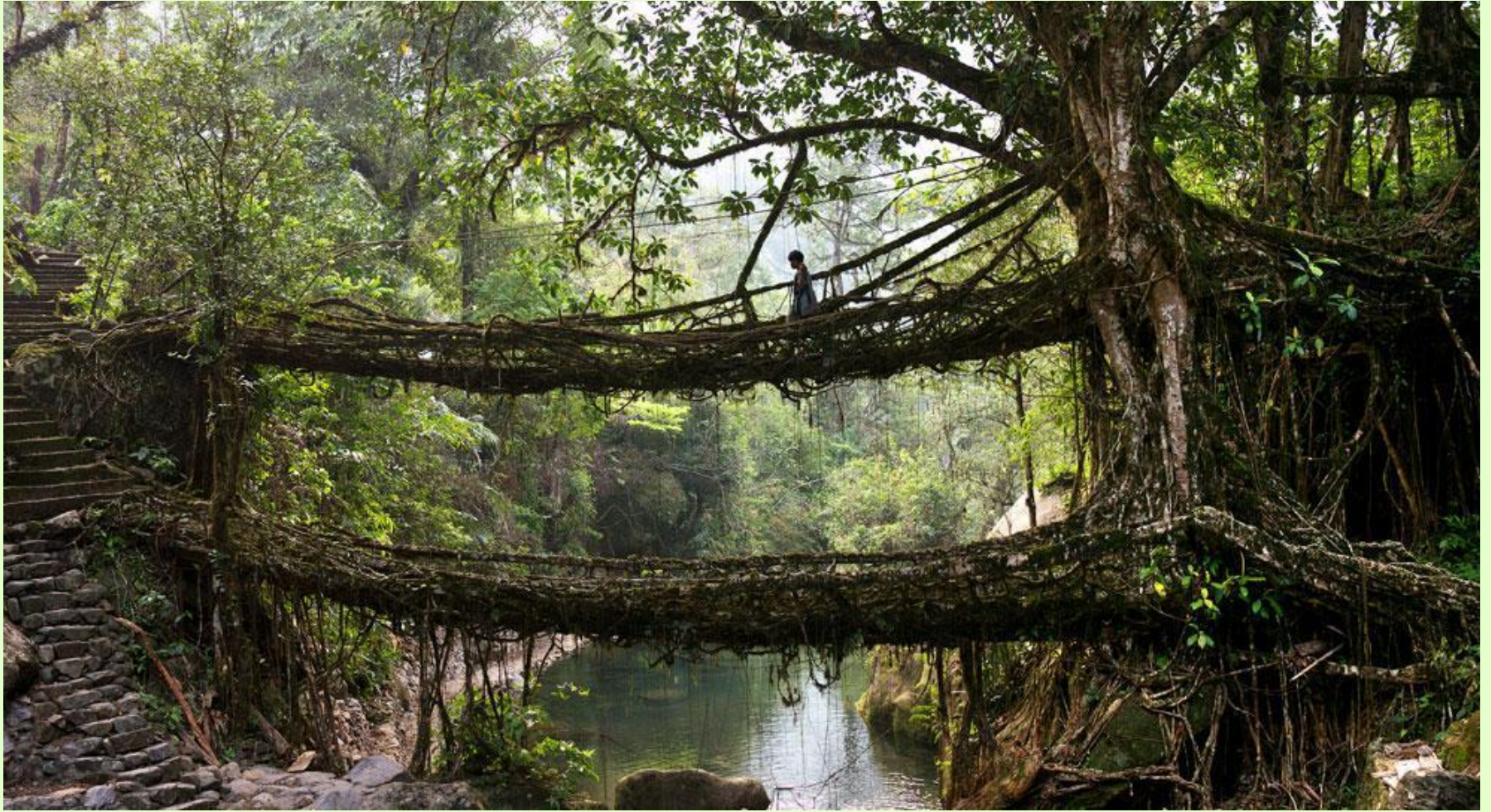
Двухуровневый мост над рекой Умшианг в Нонгриате
