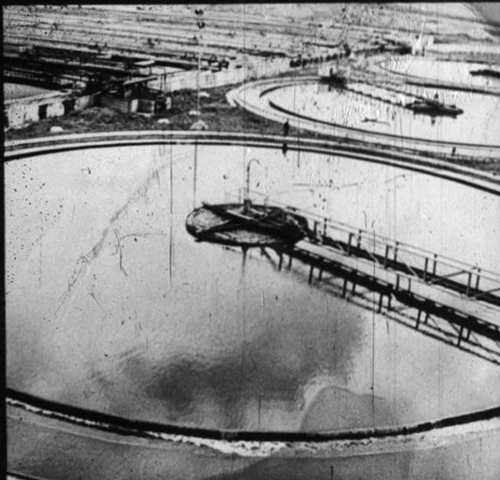
На нефтеперерабатывающем заводе.
