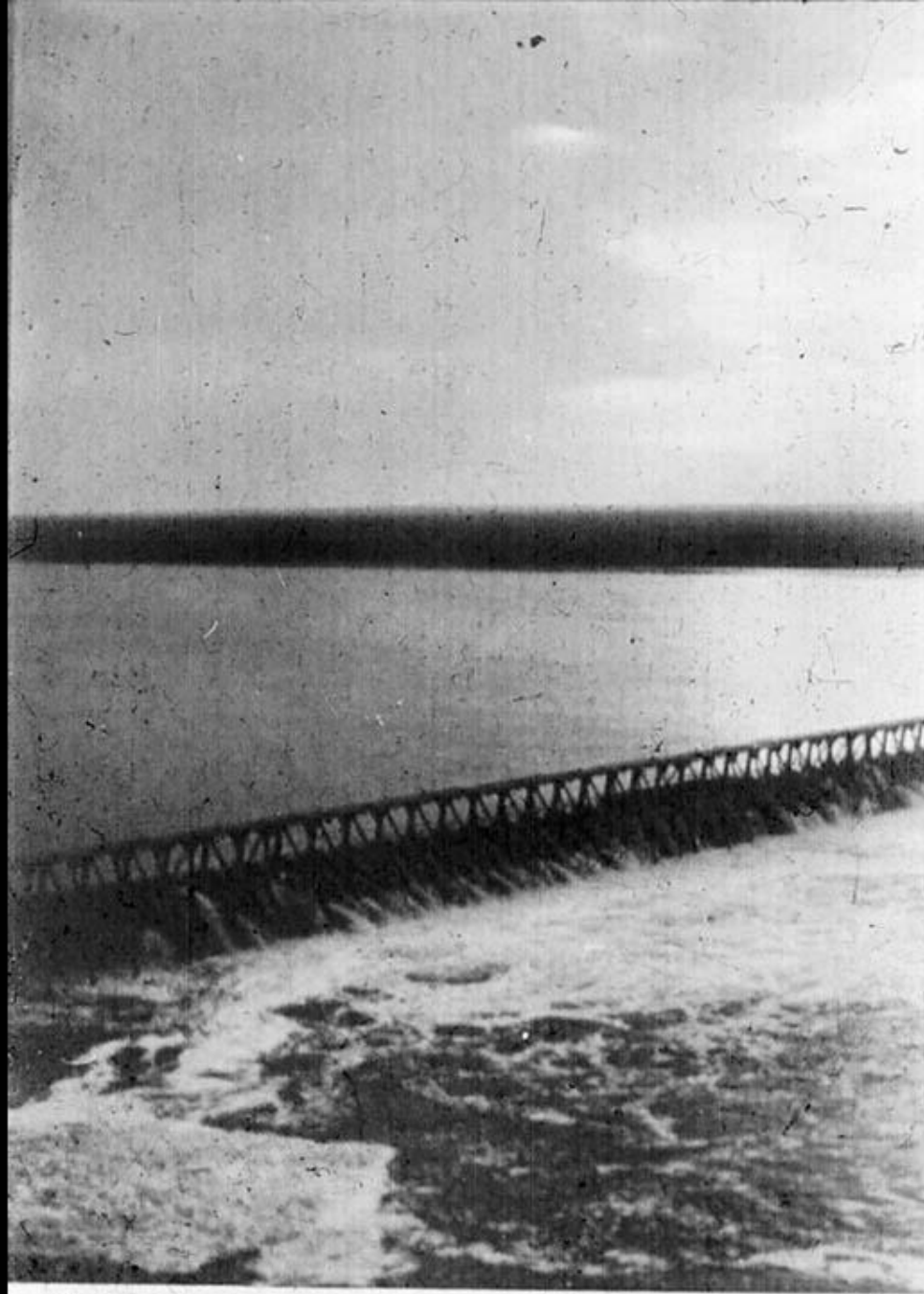
262.25 Плотина Кузьминской ГЭС
