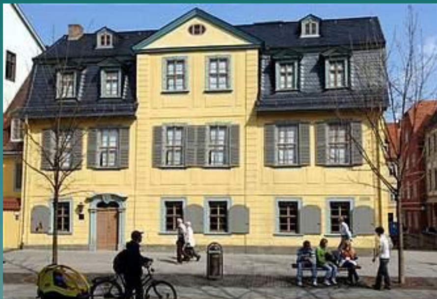
Das Wohnhaus von Friedrich Schiller in der Innenstadt von Weimar. In der Mansarde hatte Schiller seinen Schlaf- und Arbeitsraum
