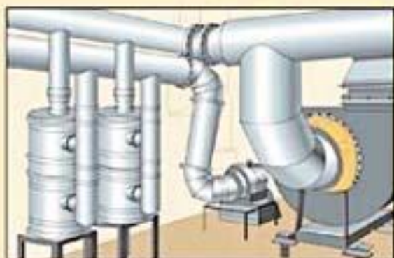
Фильтровентиляционное оборудование убежища
