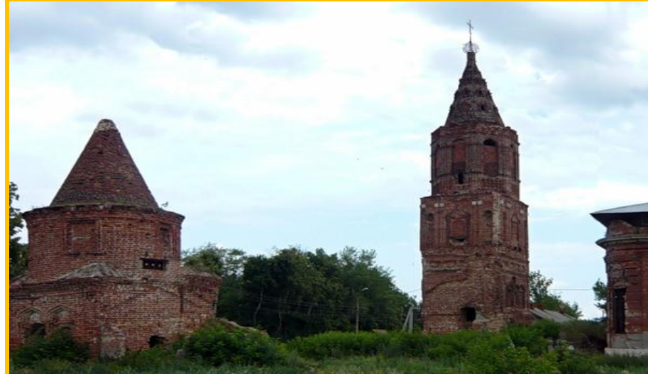
Колокольня и угловая юго-западная башня
