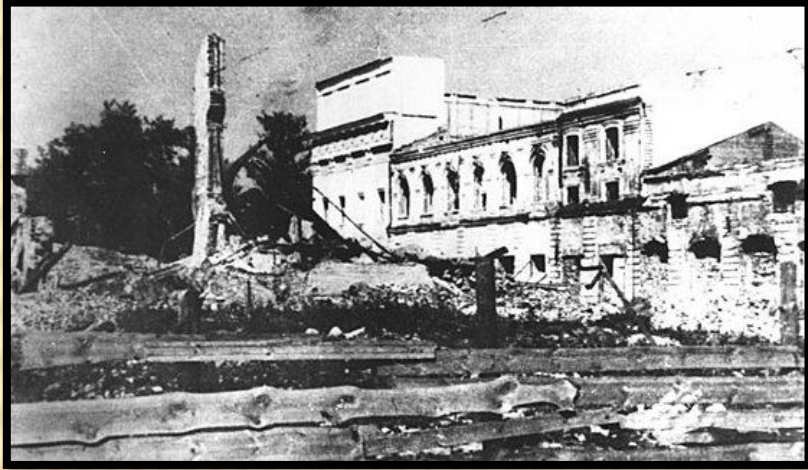
Разрушенный драматический театр.
