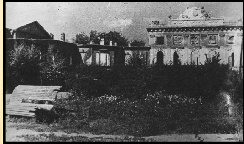
Разрушенный Путевой дворец.
