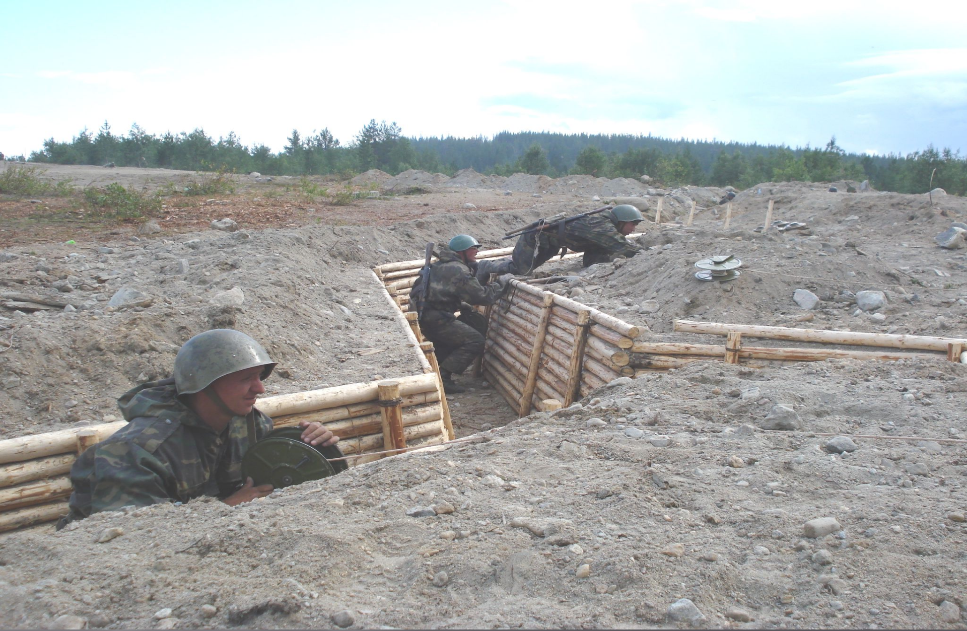
Рис. 1.14 Траншея с одеждой крутости из лесоматериала
