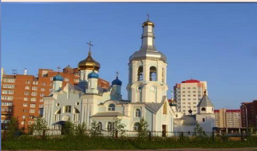
Церковь иконы Божьей матери
