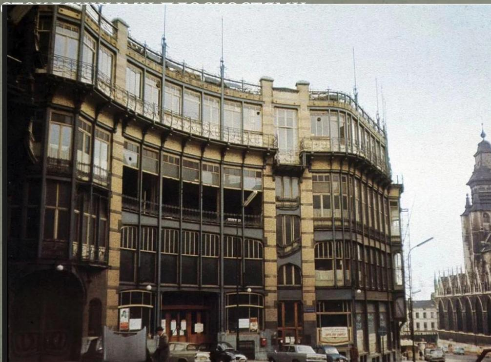
Угловой участок с выходом на площадь позволил архитектору необычно изогнуть главный фасад здания и поместить в центре вогнутой линии главный вход. В интерьере изгиб фасада выходит в обширное пространство столовой-ресторана. Над столовой размещен лекционный зал, стены которого полностью смонтированы из металлических элементов.
