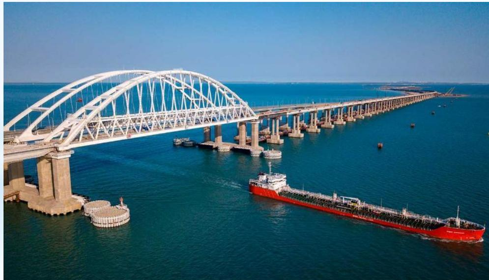
Еще немного цифр - общая длина арок моста около полукилометра. Арки весят 11,5 тысяч тонн. Для сравнения, их протяженность в 1,8 раз больше высоты Эйфелевой башни, которая весит 10 тысяч тонн. Что общего у башни в французской столице и Крымского моста? Общая технология сборных металлоконструкций, позволяющая быстро возводить сооружения.
