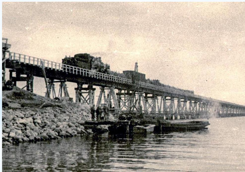
В общей сложности конструкцию держат 7000 свай (забиваются в грунт на 12 и на 90 м в море) и 595 опор. Масштабы последних впечатляют - на каждую в среднем ушло 400 тонн металлоконструкций. Полноту картины дает меткое сравнение: на конструкцию моста ушло столько железа, которого хватило бы на возведение 32 Эйфелевых башен.
