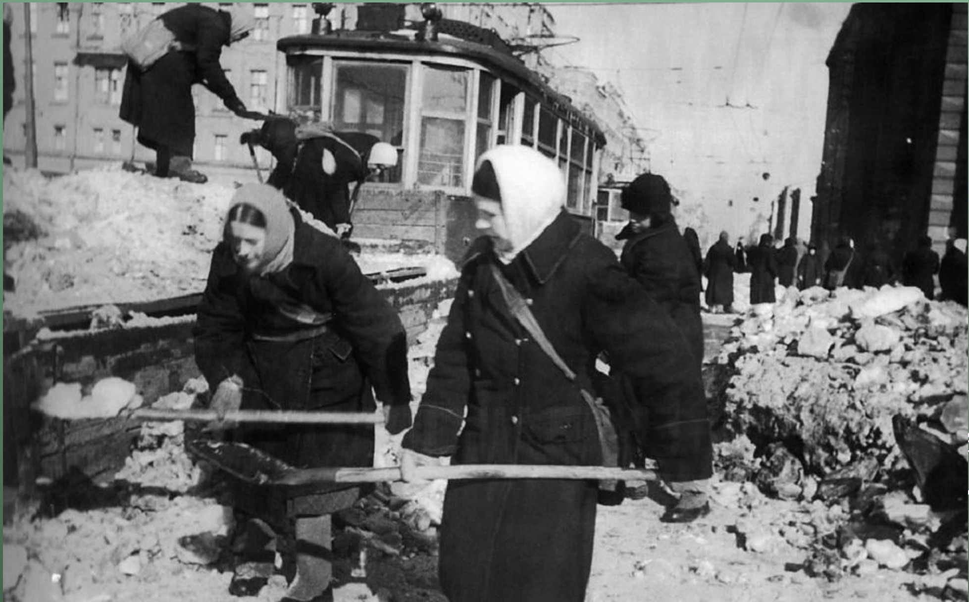
Фото: Ленинградцы расчищают улицы при помощи трамваев
