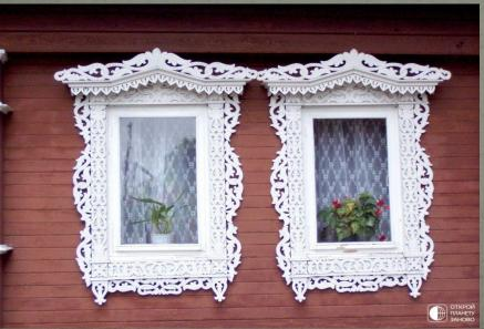
После того, как "выкройка" перенесена на дерево, нужно выпилить сначала форму изделия, то есть внешние контуры, после чего просверлить в будущих вырезах отверстия дрелью и расширить их до нужного размера и формы своим основным инструментом.
