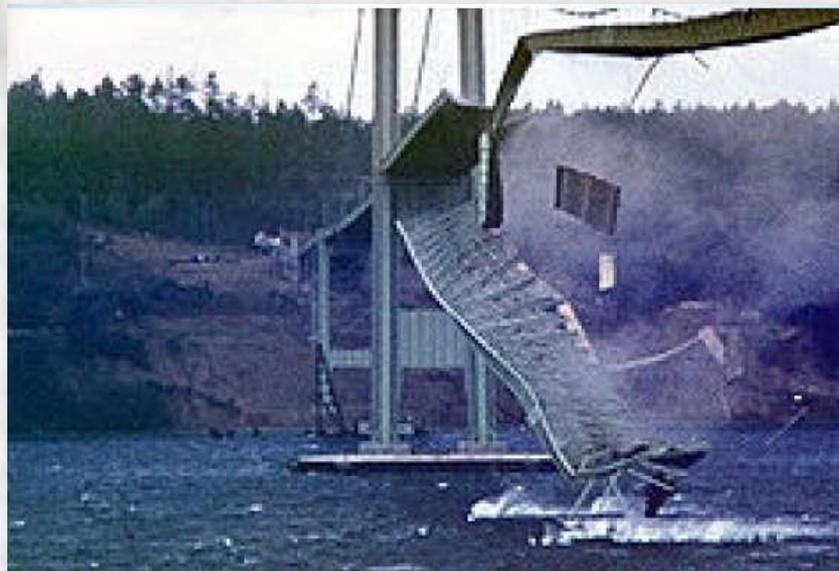
Подобное правило применяется и для поездов, которые переезжают через мост. Чтобы избежать резонанса поезд на подъезде к мосту или резко сбавляет скорость и проезжает мост на медленном ходу, или наоборот, старается проехать его на максимальной скорости. Главное, чтобы собственная частота моста ни в коем случае не совпала с частотой ударов колес о стыки рельсов.
