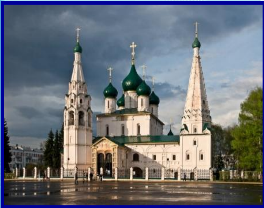
Церковь Ильи Пророка в Ярославле.
