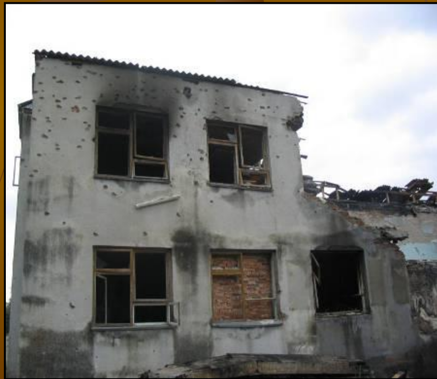
Школа, разрушенная в ходе теракта.
