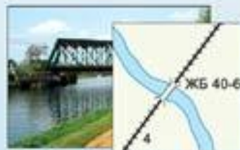
Железная дорога и железобетонный мост
