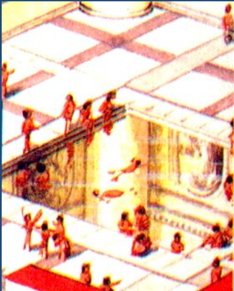
Фригидарий-бассейн с прохладной водой.
