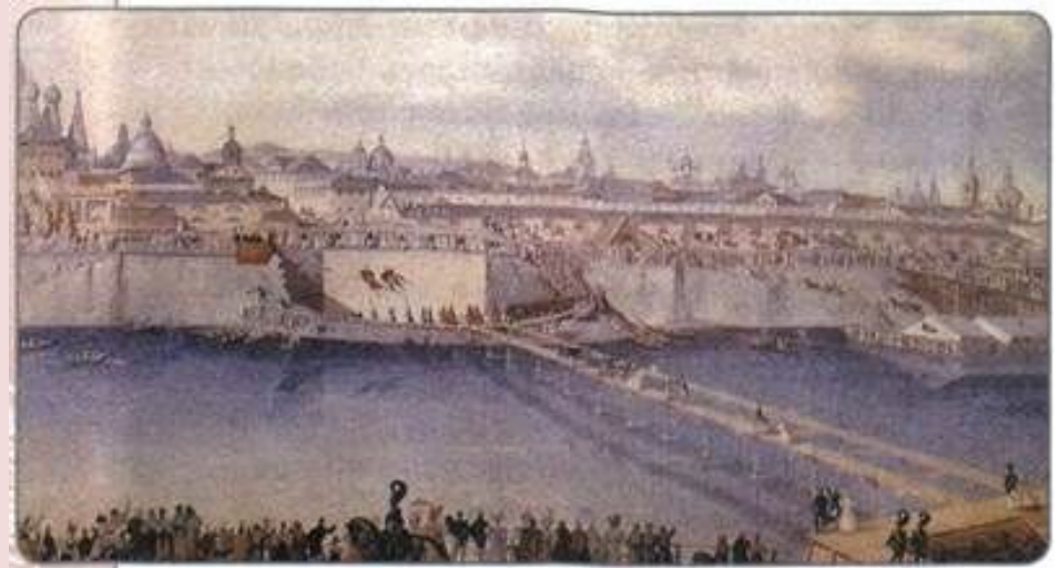
Закладка нового металлического моста через Москву-реку в 1838 г. Художник К. К. Гампельн
