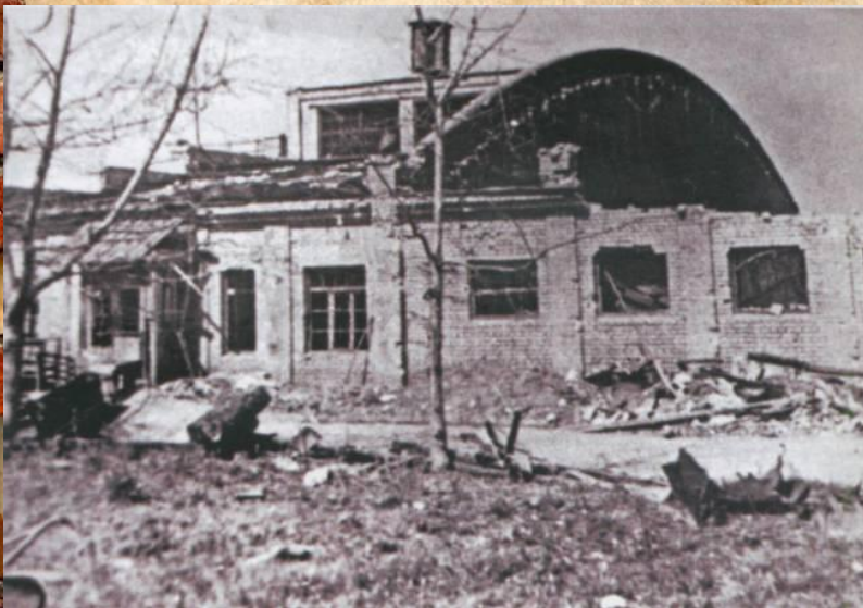
Ремонтно-механический цех Крекинг-завода после авианалета.
