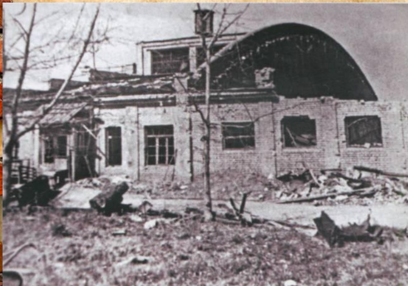
Ремонтно-механический цех Крекинг-завода после авианалета.
