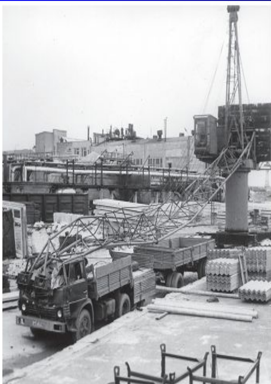
Рис. 23. Место аварии башенного крана БКМ-511
