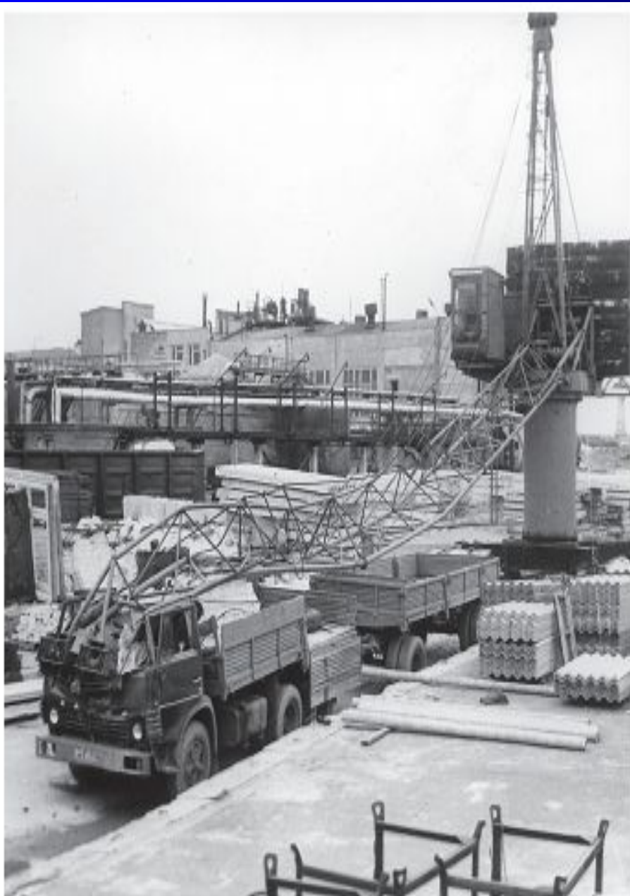
Рис. 23. Место аварии башенного крана БКМ-511
