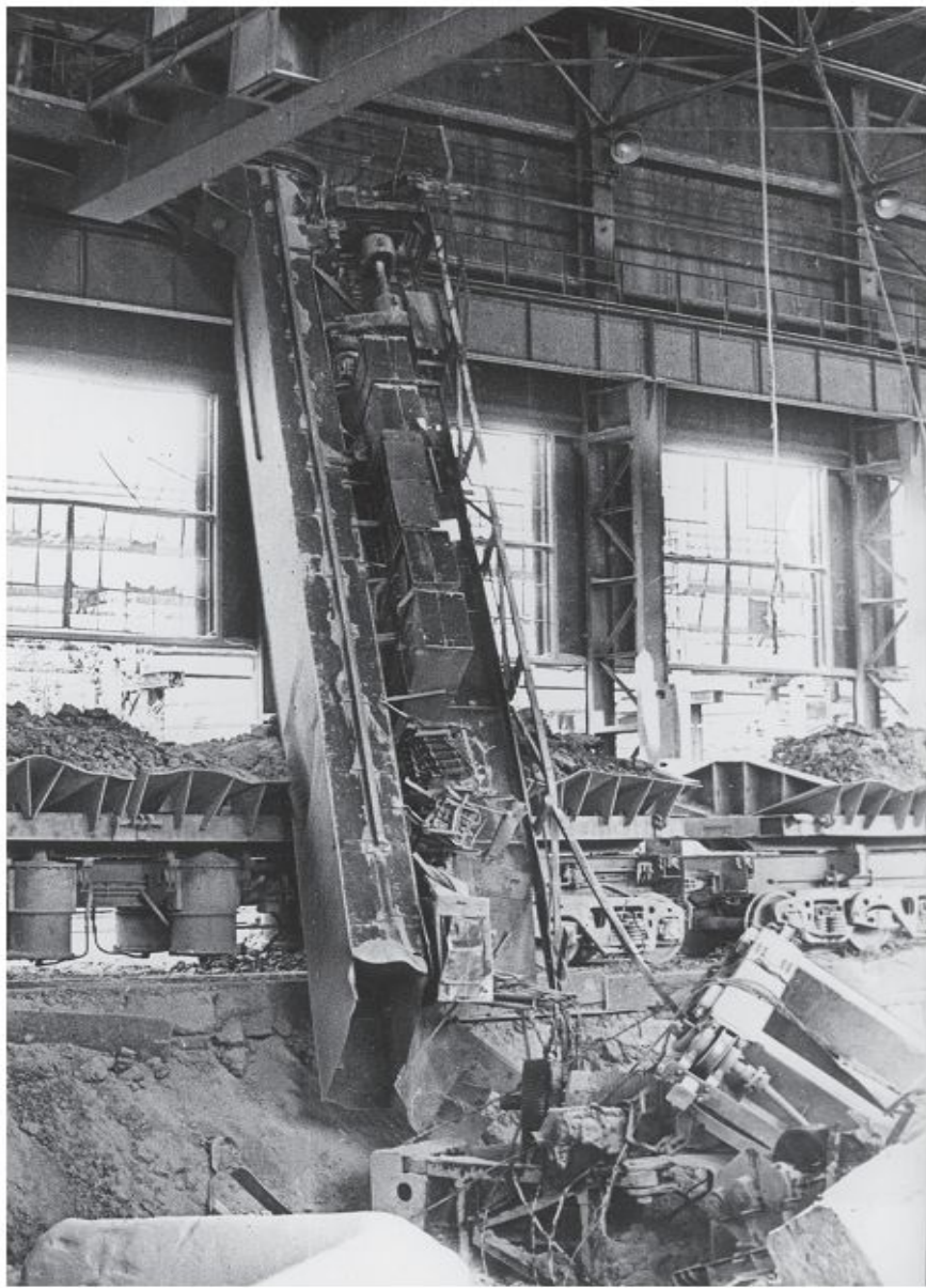
Рис. 5. Место аварии мостового магнитно-грейферного крана грузоподъемностью 15 т
