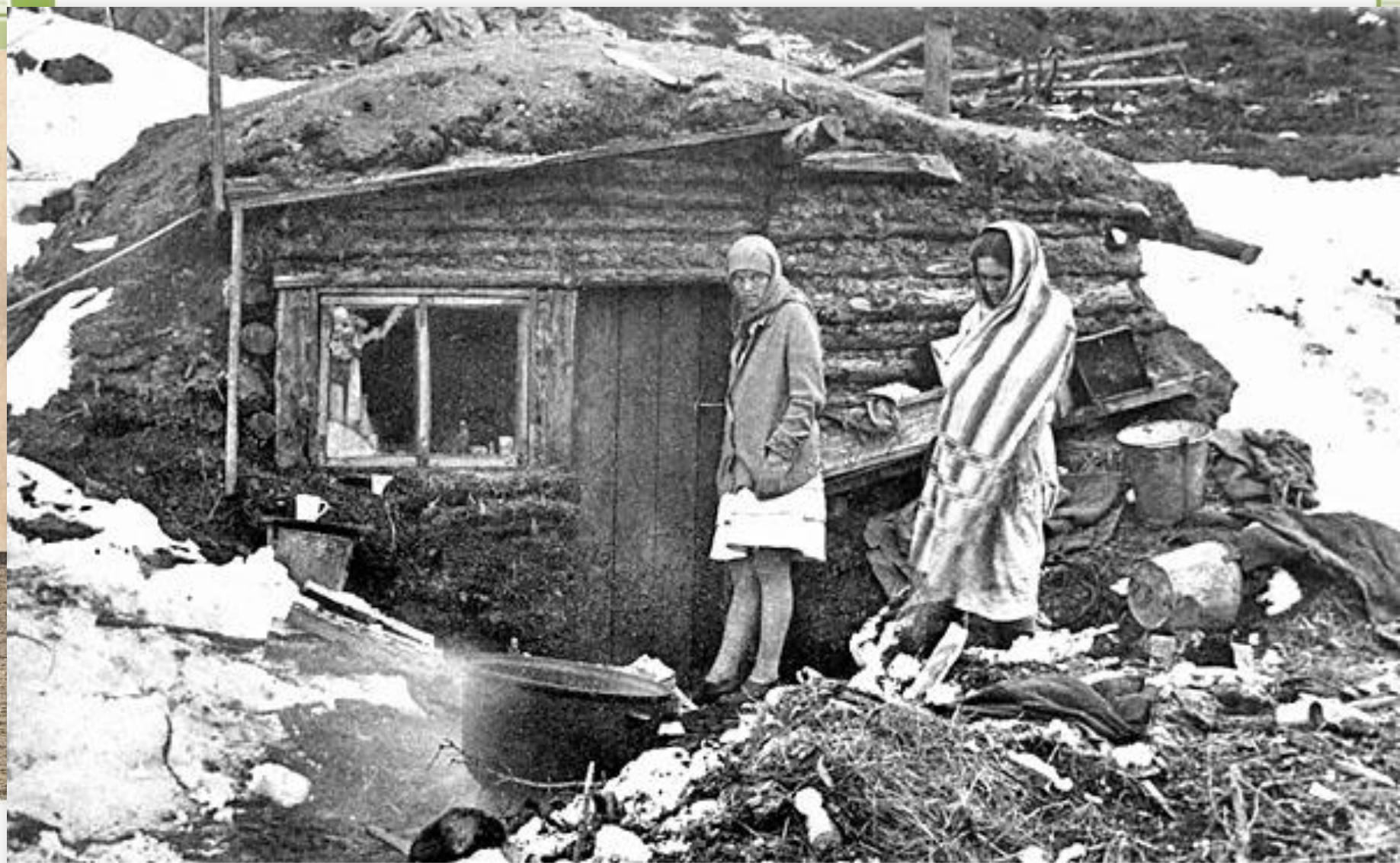
Строители Горок жили в землянках
