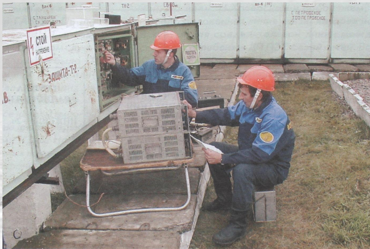
Служба МСРЗАИ на объекте: Платонов А.В. - инженер МСРЗАИ, Скоков А.П. - эл.монтер МСРЗАИ
