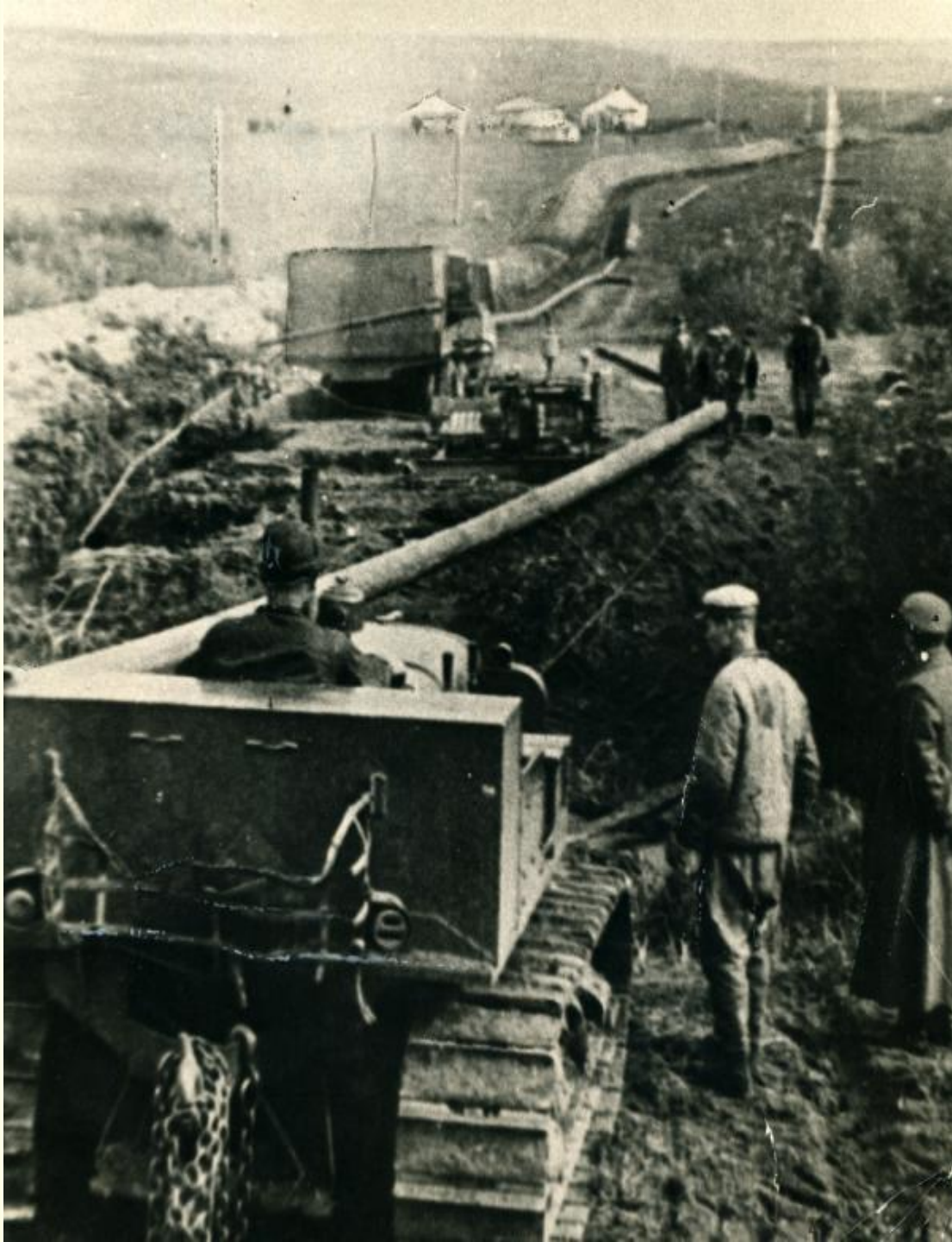
На трассе строительства газопровода «Саратов-Москва». 1945.
