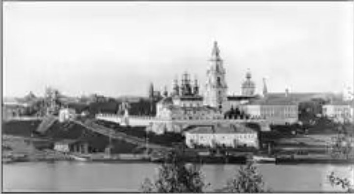
Сооружение соборного комплекса в Костромском кремле
