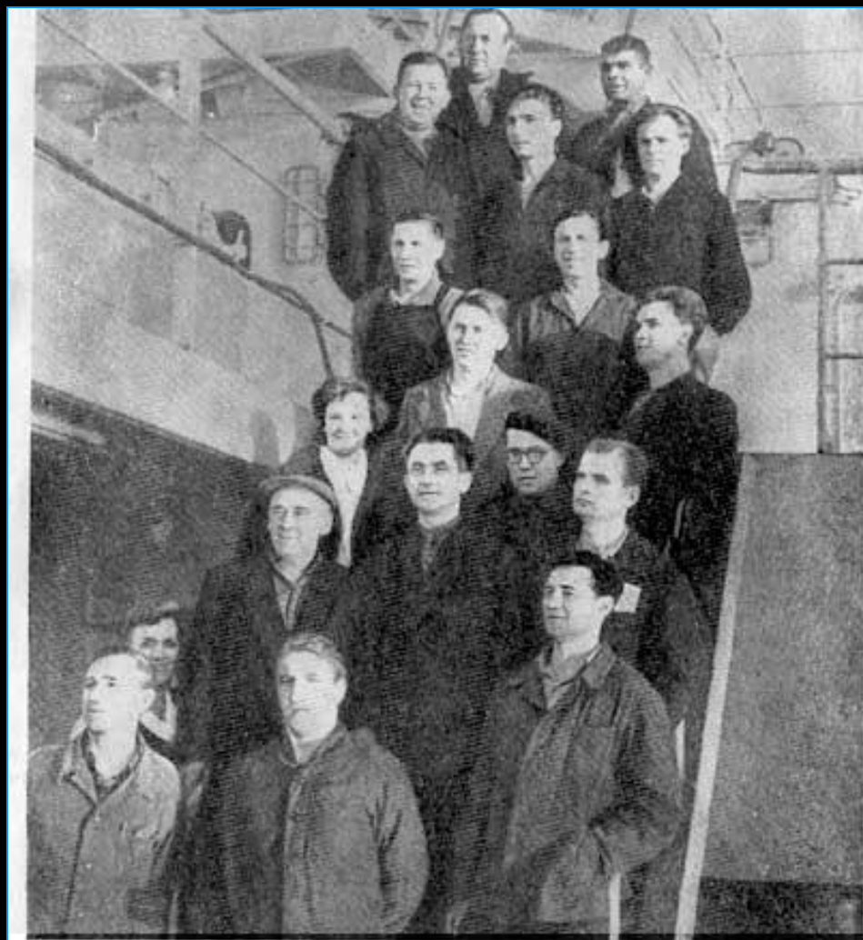
Группа участников монтажных работ
