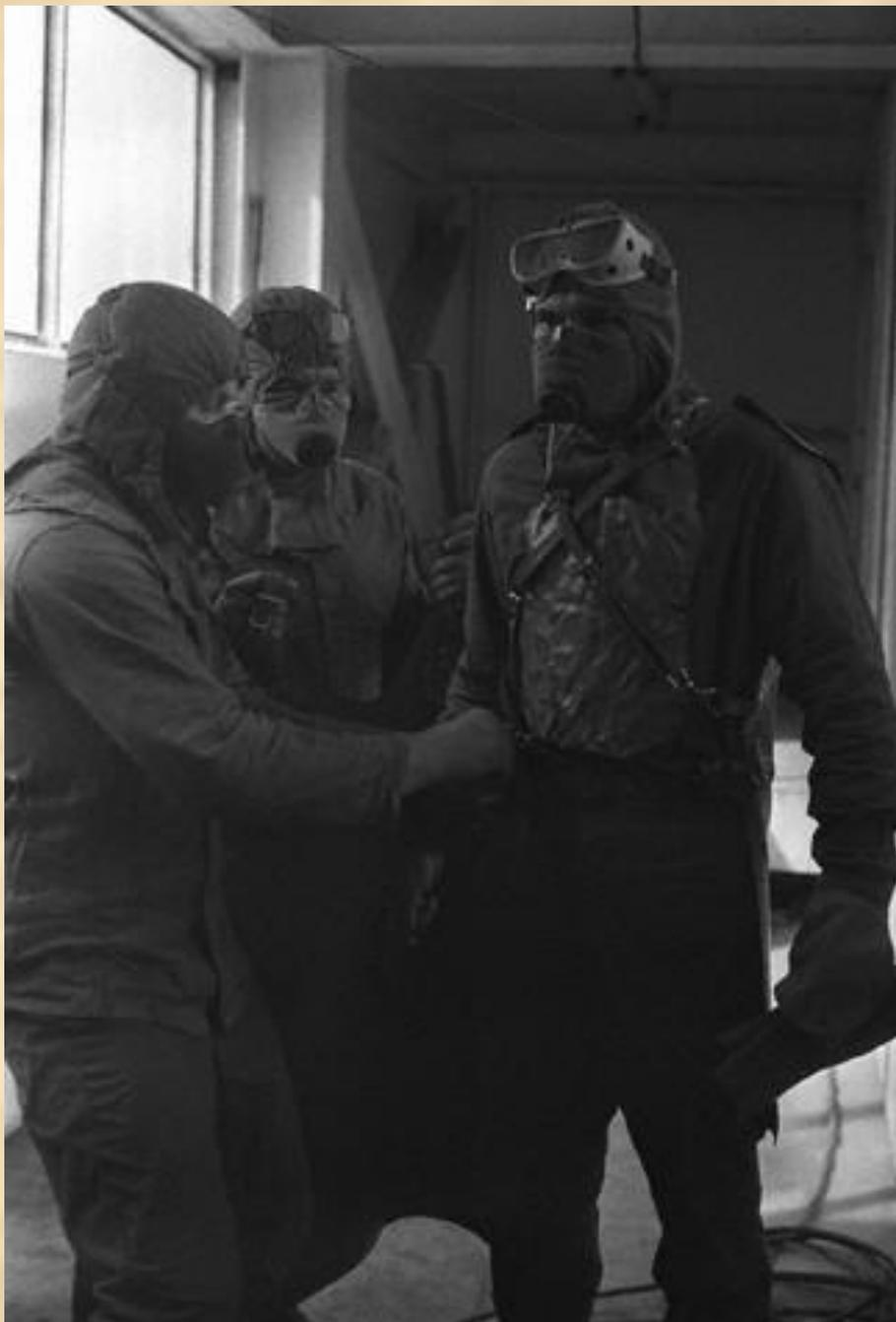
**Те, кто был назначен работать в наиболее опасных зонах, были одеты в собственную форму или одежду, и единственной защитой служили сшитые свинцовые пластины толщиной 2-4 мм и простые респираторы. Сверху надевались резиновые фартуки.**
