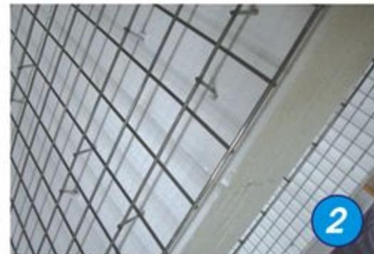
3 Монтаж стен здания начинается с установки панелей на монолитный ленточный фундамент, или монолитную плиту. В соответствии с чертежами проекта, размечается положение арматурных стержней. Арматурные стержни служат для простаты монтажа стеновых панелей и не воспринимают горизонтальных нагрузок.
