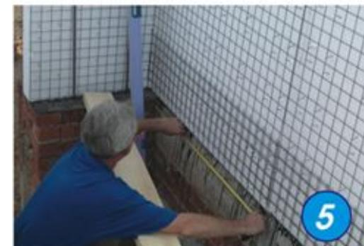
5 Установка панелей в проектное положение по направляющим арматурным стержням и выверение их по вертикальному уровню.
