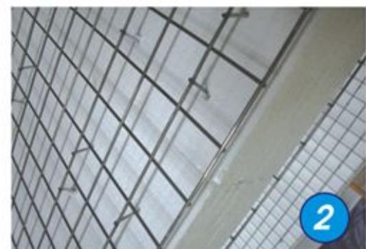
2 За счет диагональных поперечных стержней, приваренных к сварной проволочной арматурной сетке с каждой стороны, стеновая панель обладает высокой прочностью и упругостью.
