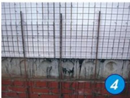
5 Установка панелей в проектное положение по направляющим арматурным стержням и выверение их по вертикальному уровню.
