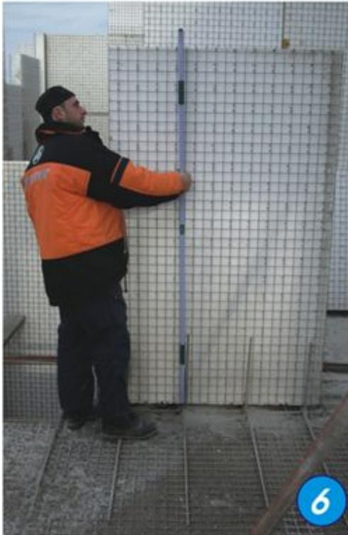
6 Установка панелей в проектное положение по направляющим арматурным стержням и выверка по вертикали.
