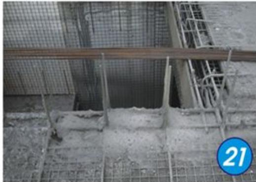
Для обеспечения необходимой защиты от коррозии требуется, чтобы толщина бетона с внутренней стороны здания как минимум составляла 40мм. Для внешней стороны здания данный показатель увеличивается до 50мм. Как правило, на панели «3D» с внешней стороны наносится слой торкретбетона 50-60мм.
