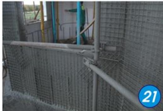
Бетон на стенах и нижней части плит наносится обычно, как торкретбетон. Однако существует возможность нанесения бетона вручную, особенно это применимо при нанесении второго, финишного слоя. Верхняя сторона плит обычно покрывается бетонной смесью, подаваемой из насоса.
