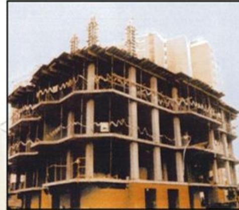
**В высотном монолитном строительстве панели «3D» используются как несущие конструкции**
