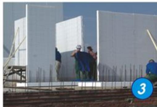
4 Арматурные стержни диаметром 10мм устанавливаются с шагом 50см в просверленные отверстия в соответствии с чертежами проекта (с внутренней стороны несущих стен). В случаях возникновения особой необходимости (например ветровые нагрузки на консольные стены) арматурные стержни должны быть установлены с обеих сторон на небольших расстояниях в соответствии со строительными расчетами.
