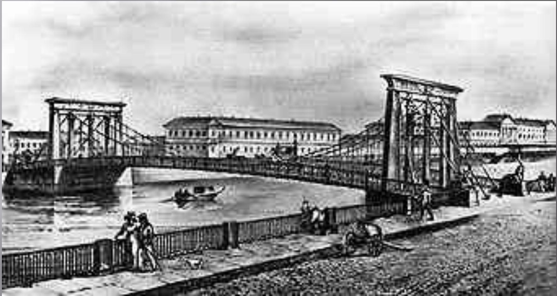
Мост был открыт 25 августа 1826 года. Сооруженный по проекту **Г. Треттера** и под непосредственным руководством военного инженера **П. Христиановича**, он представлял собой однопролетный цепной, на береговых устоях, проезжий мост.
