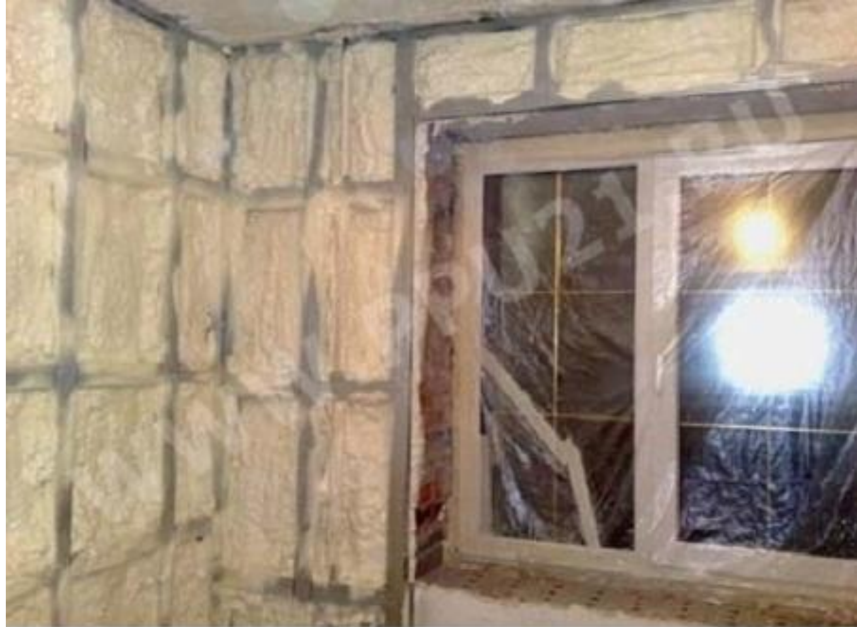
Утепление стен изнутри в коттедже
