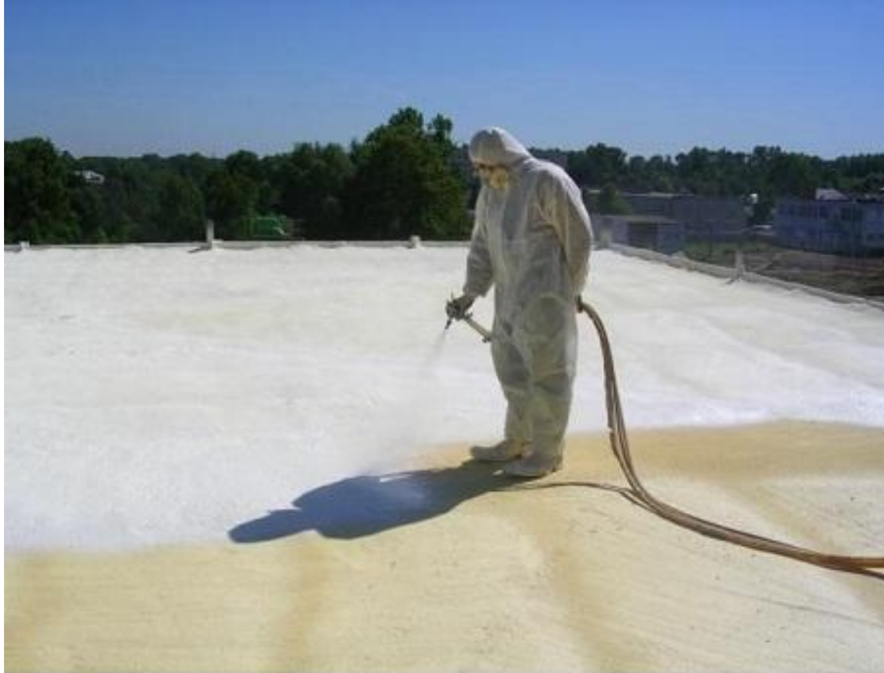
Наружная теплоизоляция крыши
