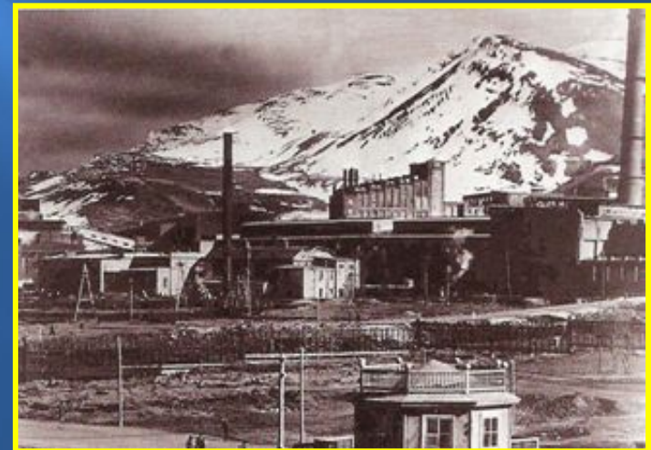
Малый Металлургический завод
