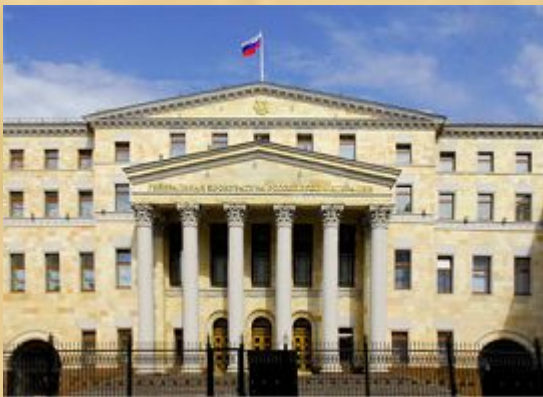
Здание Генеральной прокуратуры РФ
