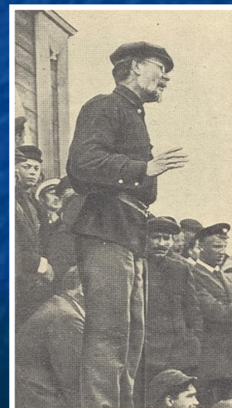
М. И. Калинин выступает на митинге строителей Волховской ГЭС
