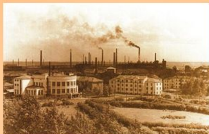
Вид на завод со стороны ДКМ. 1950-е годы
