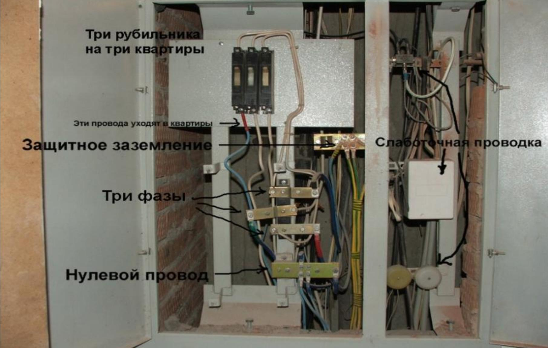
**Ремонт и поиск неисправностей при замыкании
