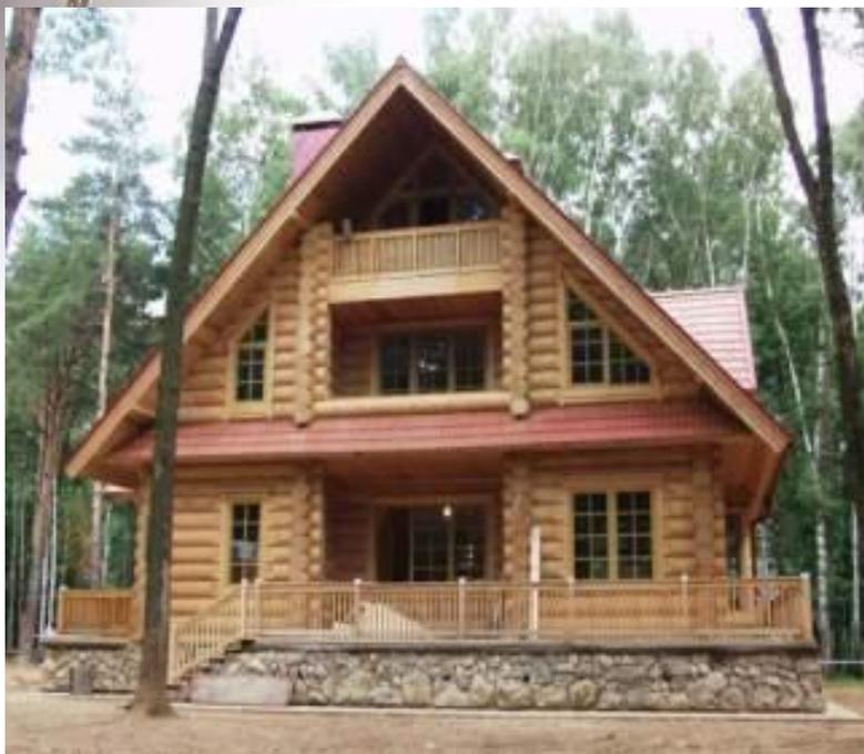
В строительстве деревянных домов используются оцилиндрованное бревно, профилированный брус – простой или клееный – и ошкуренное бревно, подвергнутое минимальной обработке.
