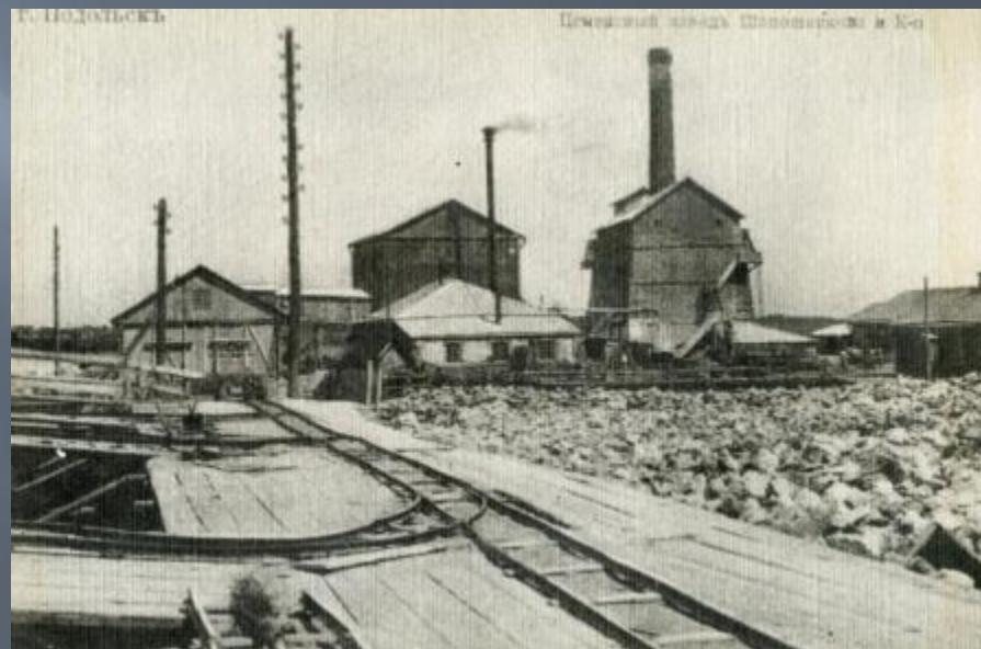
Цементный завод 1875 г.
