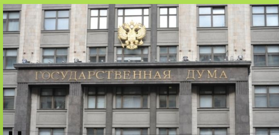
На зданиях госучреждений
