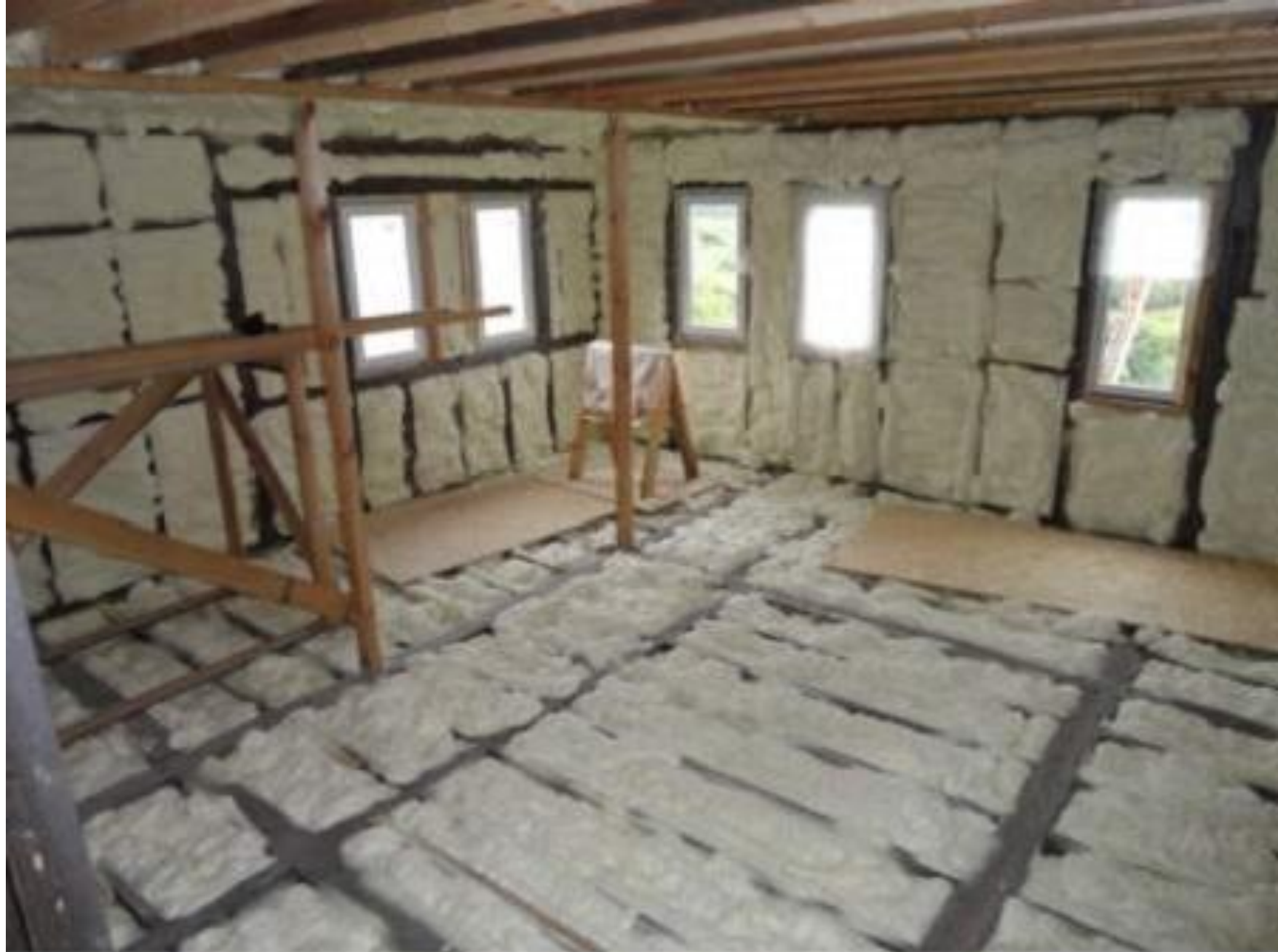
Внутреннее утепление стен, пола, потолка дома
