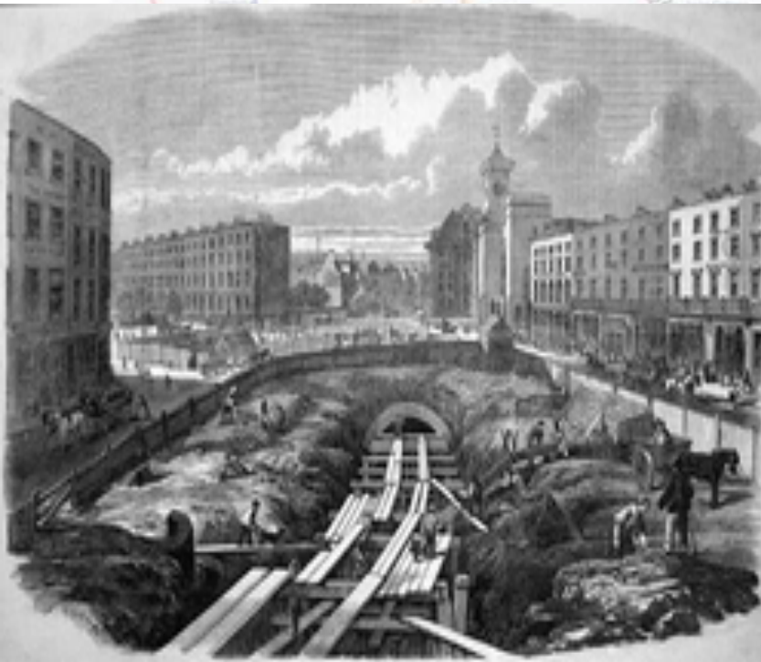
Строительство «Метрополитен рейлуэй» вблизи вокзала Кингс-Кросс (1861 г.)
