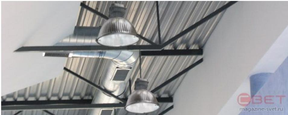
Искусственное освещение сварочных цехов и кабин должно быть комбинированным — из общего и местного освещения. Освещенность рабочих мест — не менее 80—100 лк.
