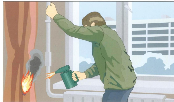
Отогревание замёрзших труб паяльными лампами и факелами
