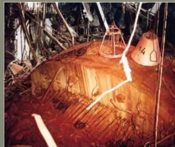
Крышка реактора после взрыва
