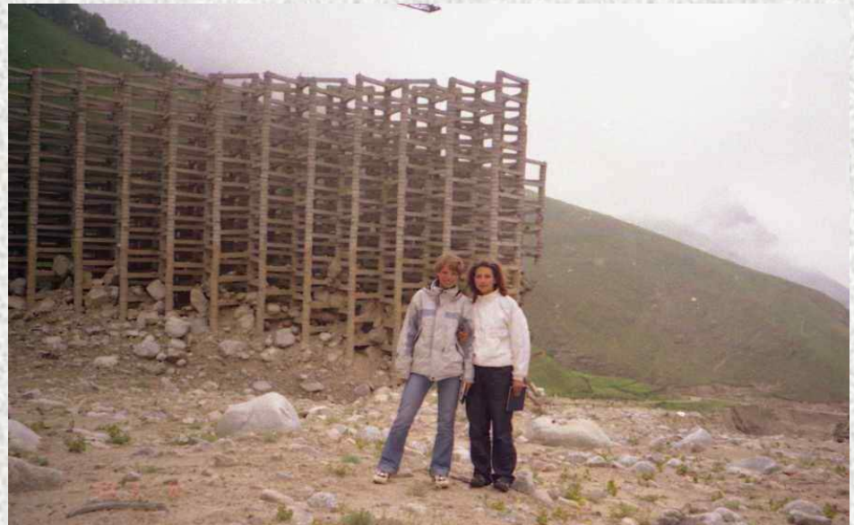
Селезащитное укрепление на Кавказе
