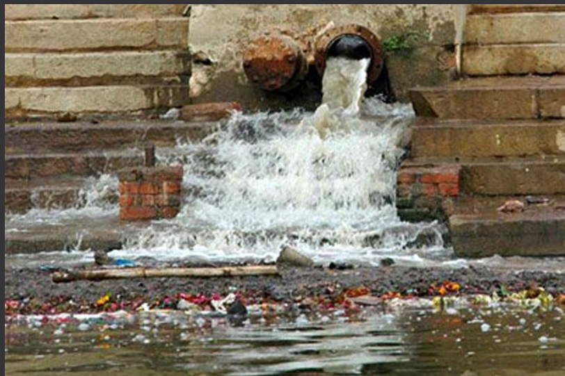
Авария на очистных сооружениях в Курске
