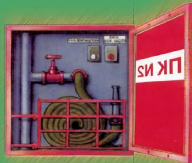
ПОЖАРНЫЙ КРАН В ЗДАНИИ
