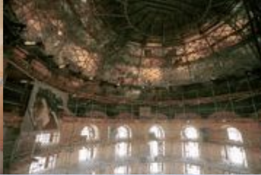
Строительные леса внутри центрального купола, изготовленные на заводе "МИГ" (высота подкупольного пространства около 15 м).
