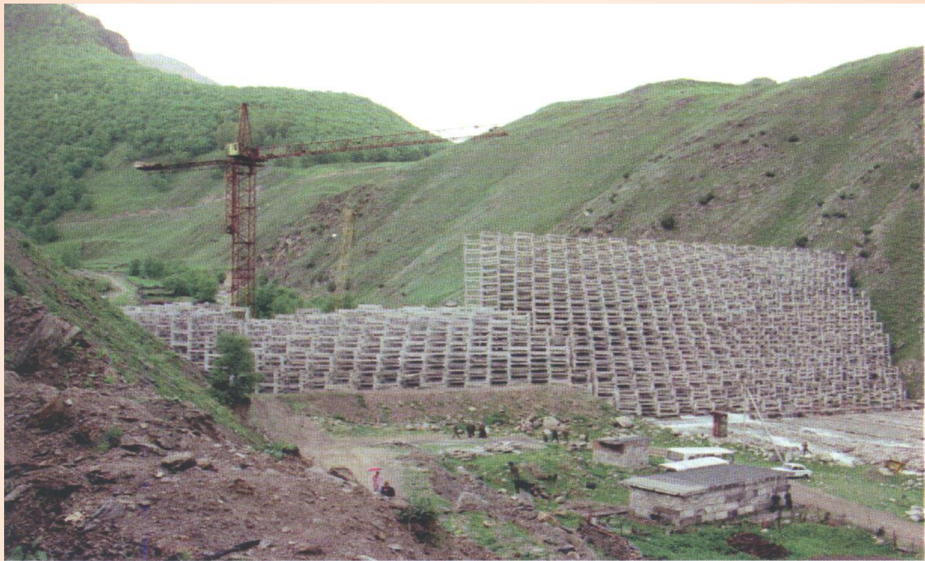
Строительство селезащитной плотины в Кабардино-Балкарской республике
