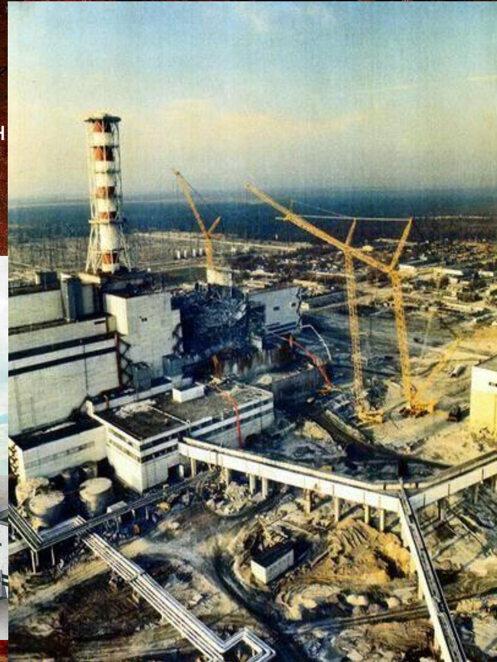
Второй взрыв — смеси водорода с воздухом — разрушил здание 4-го блока
