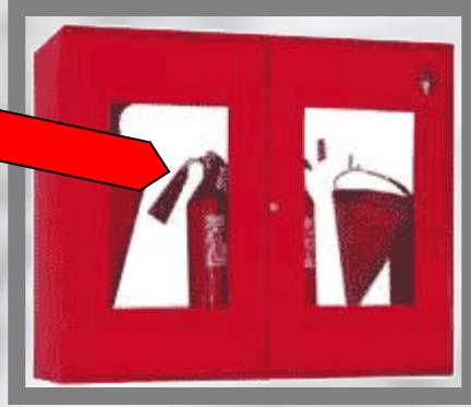
Огнетушители должны устанавливаться таким образом, чтобы был виден имеющийся на его корпусе текст инструкции по использованию. Конструкции и внешнее оформление тумб и шкафов для размещения огнетушителей должны позволять визуально определить тип установленных в них огнетушителей.
